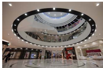
LED照明にした館内通路
