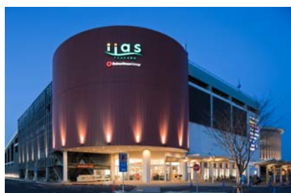
LED照明にした外壁照明
