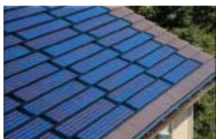
太陽光発電システム
