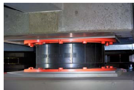
免震システム
