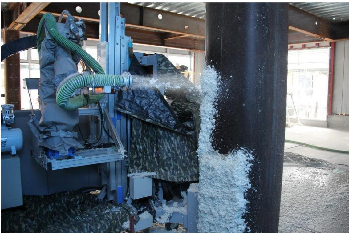
「耐火被覆吹付ロボット」によるロックウール・モルタル吹付作業
