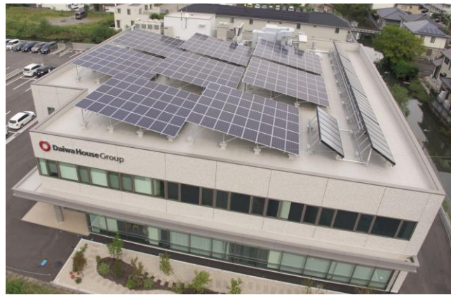
【大和ハウス佐賀ビル】
