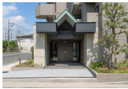
エントランス（外部）をバリアフリー化ならびにオートロックを新設
