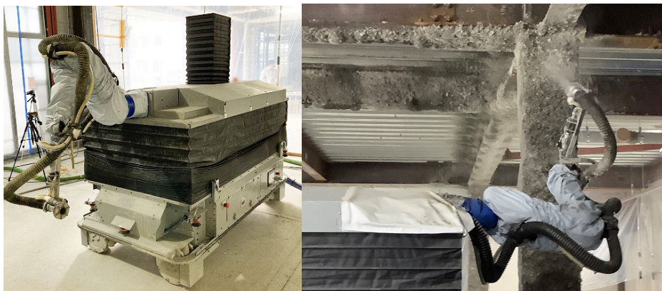
【耐火被覆吹付ロボット】
