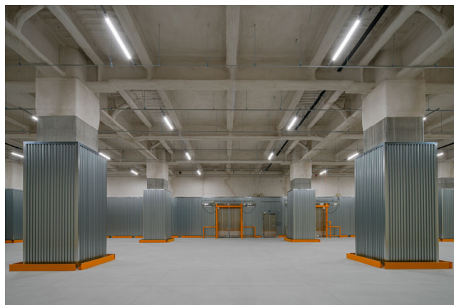
「DPL大阪舞洲」冷凍冷蔵倉庫内
