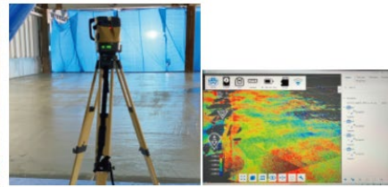
コンクリート荒均しを可視化
