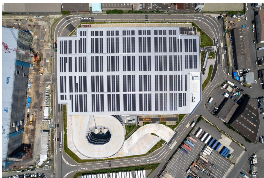
【太陽光発電システム】
