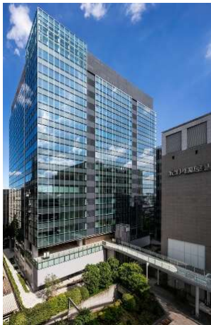
▲JR「新宿」駅新南口直結の既存デッキ
