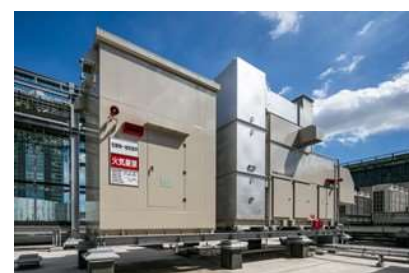
▲非常用発電設備
