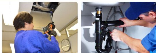
内視鏡 配管など目視できない場所の汚れや故障部分のチェックに
