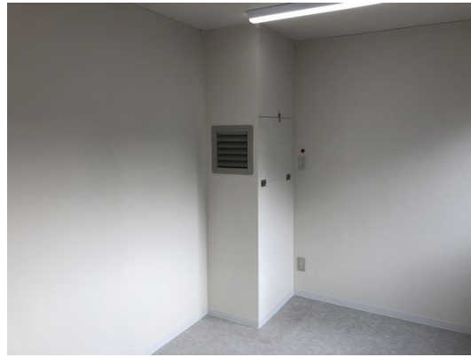
独自開発した陰圧装置を室内に内蔵しています
