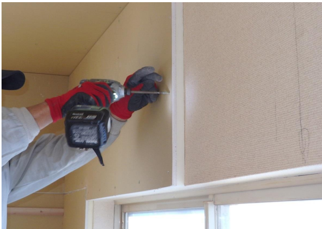
既存壁への上張り断熱リフォーム(断熱複合パネル使用)
