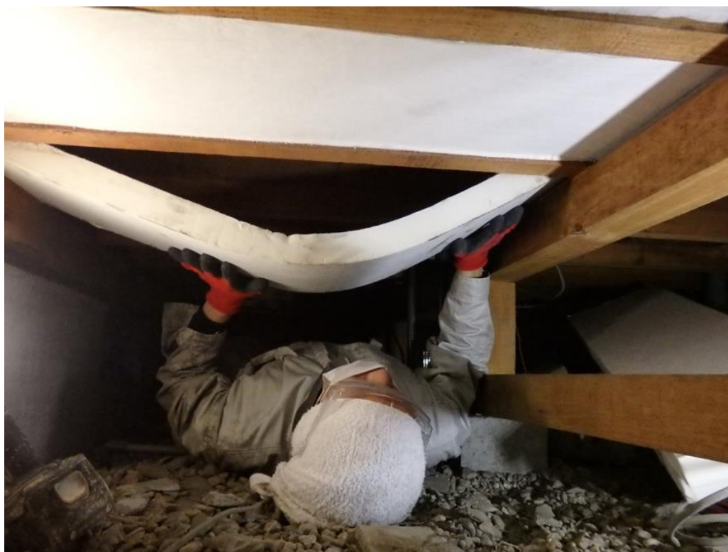
既存床下からの断熱リフォーム(断熱ボード使用)
