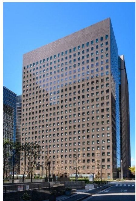
・大手センタービル
