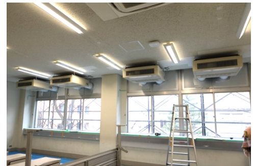
換気設備工事
