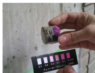
中性化深さの確認試験の様子
