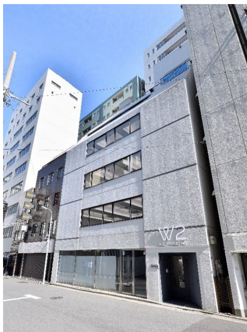
「W2 KODENMACHO」外観
