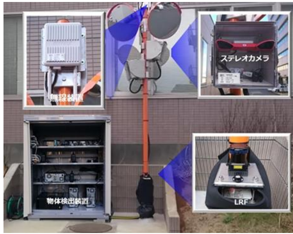
図 2: YRP に設置した電子カーブミラーとその構成
