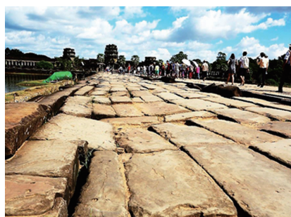
参道入口付近より 第2工区(左側)をのぞむ
