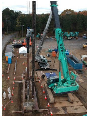
写真-1 固化工程専用機
