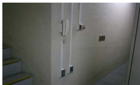
写真5 非常電源も消失した場合に備えて、電源スイッチにも蓄光+反射テープを設置したことで暗い室内でも認識ができる。
