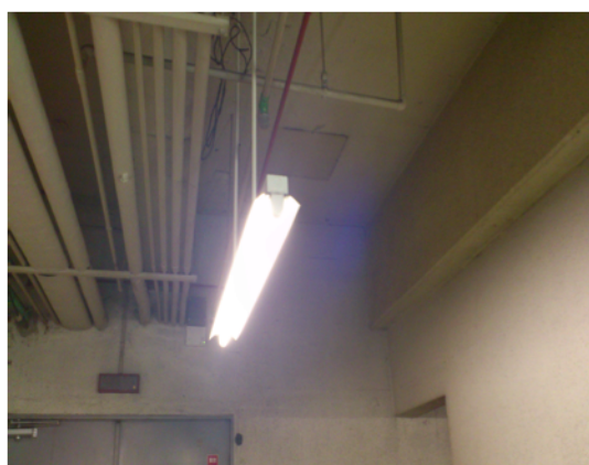
写真2 蓄光入りの蛍光灯カバーは電気が消えると励起されていた電力が燐光され周囲を明るくする。 (表1 No.③)
