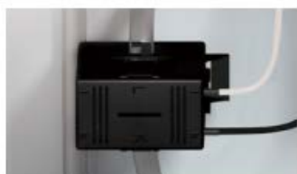
専用CTをケーブルに取り付けた例
