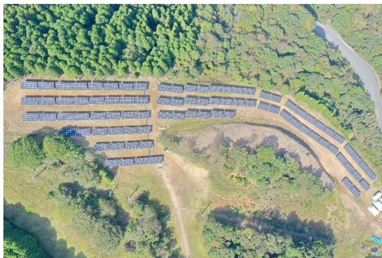
オムロン宮津太陽光発電所
