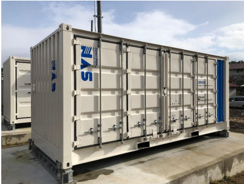
オムロン宮津太陽光発電所に設置した大容量蓄電池 NAS@電池(日本ガイシ株式会社製)
