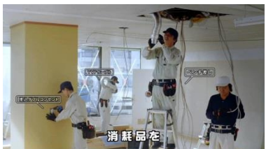
屋内電気工事
