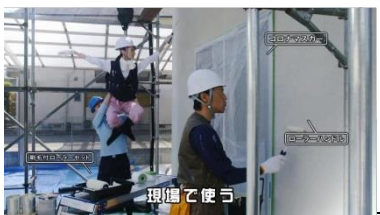
外壁塗装工事
