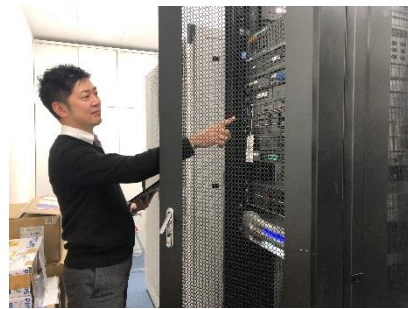
システム点検の様子
