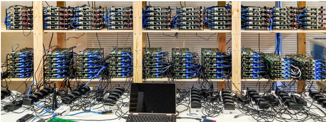
図 1 1,000 台の Wi-SUN FAN 無線機を用いた実際の試験の様子
