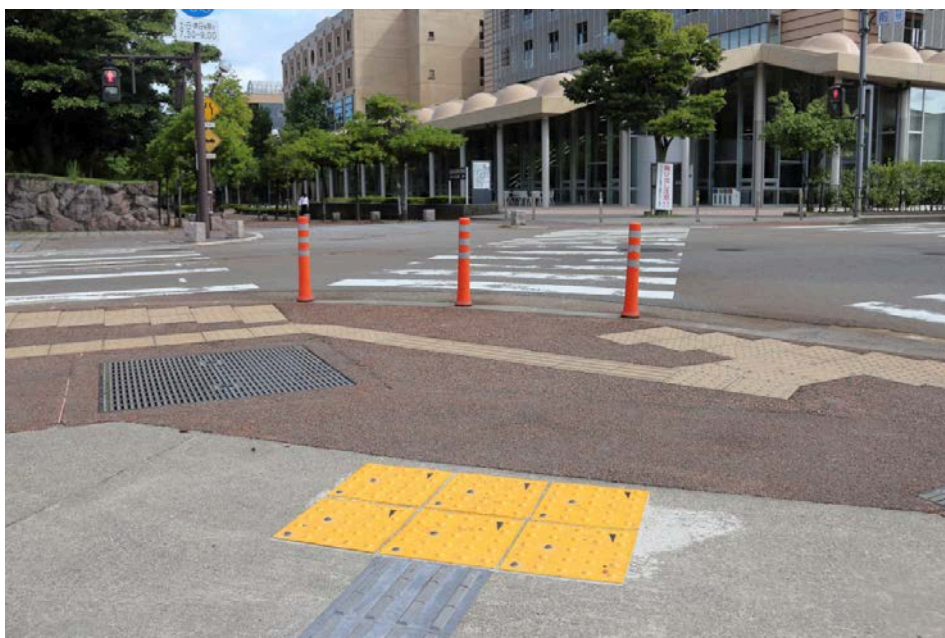
扇が丘キャンパス南校地通用門に敷設されたコード化点字ブロック
