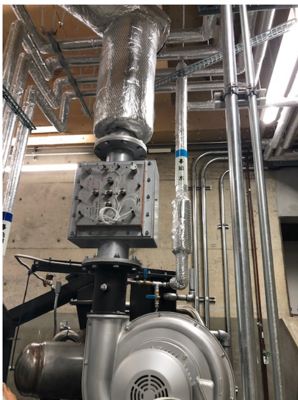
バイオマスボイラーの排熱で発電する熱電発電装置(写真中央 正方形の装置) 出力最大 240W
