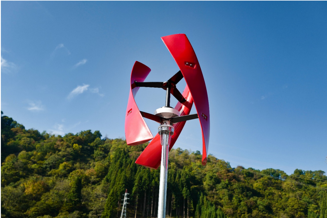
白山麓キャンパス Innovation Hub の屋上に設置された風力発電装置。出力最大 300W
