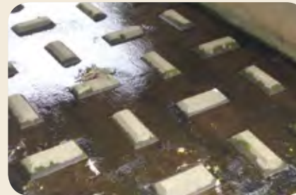
床止工（護床工）
