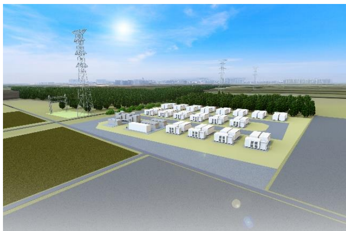
水戸蓄電所イメージ
