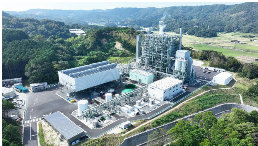
(唐津バイオマス発電所／2024年9月撮影)
