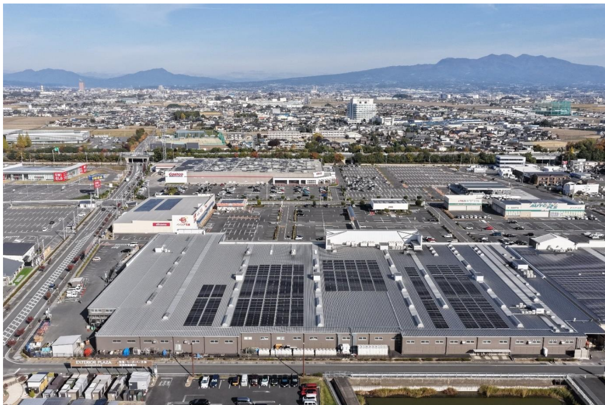
ベイスシア前橋みなみモール店が入居する商業施設 パワーモール前橋みなみ内の太陽光発電設備
