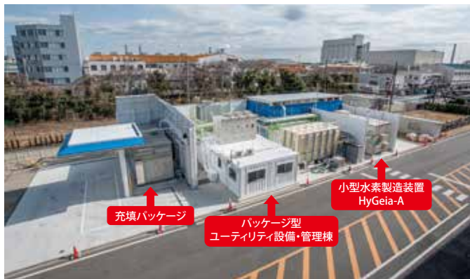
三菱化工機(株)川崎製作所内にある実証用水素ステーション
