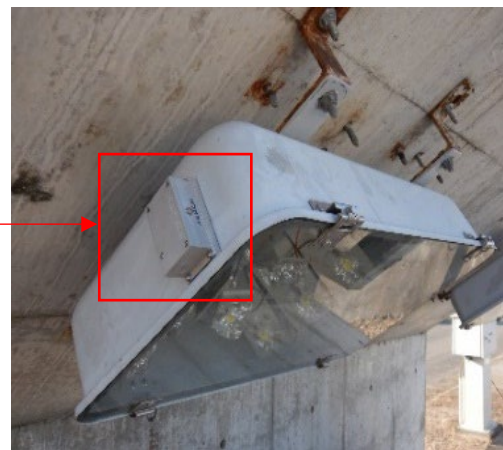
写真2 照明灯具への取付状況
