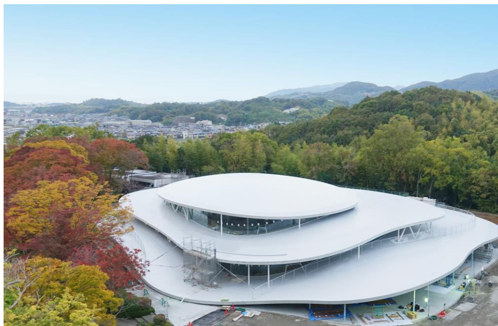
アートサイエンス学科 新校舎（建設途中）
