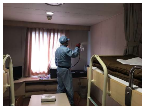
▲客室 施工風景
