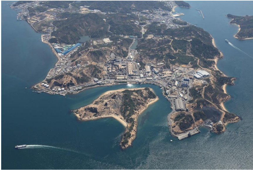
直島製錬所外観
