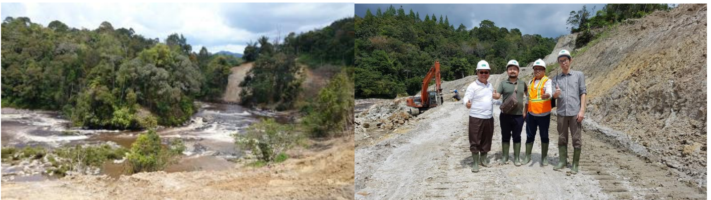
水力を活用する北スマトラ州の河川(左)／ 建設現場でのCA社関係者と当社スタッフ(右)
