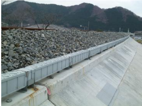
旧南リアス線盛地区 グリーントラフ®施工箇所 ©古河電気工業株式会社
