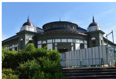
外観（修理工事中）
