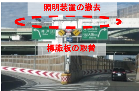
案内標識の取替えと照明装置の撤去
