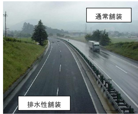
排水性舗装の施工例
