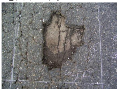
舗装の損傷状況
