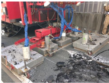
IHヒーターによる加熱状況
