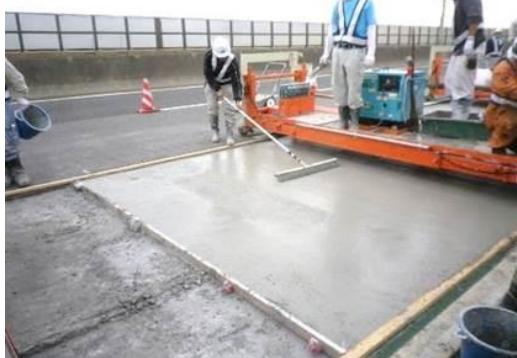
SFRC舗装により鋼床版の耐久性を向上
