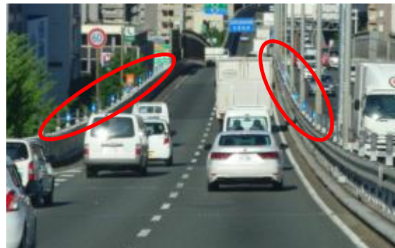
速度回復誘導灯（高欄上部）
