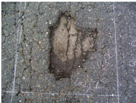
舗装補修の損傷状況
