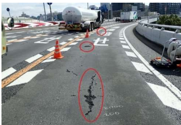
1号環状線の舗装の損傷状況
