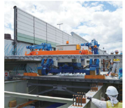
UFC 床版架設工事の状況（玉出入口）
