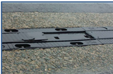
損傷事例（ゴムジョイントのはがれ）
