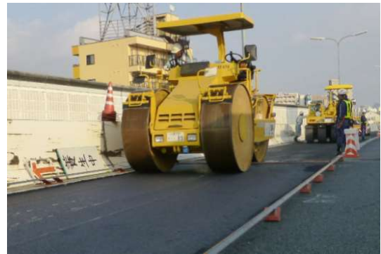
舗装補修の施工状況
