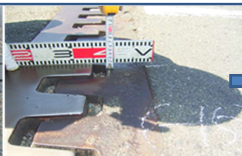
損傷事例（鋼製ジョイントの浮き・段差）
