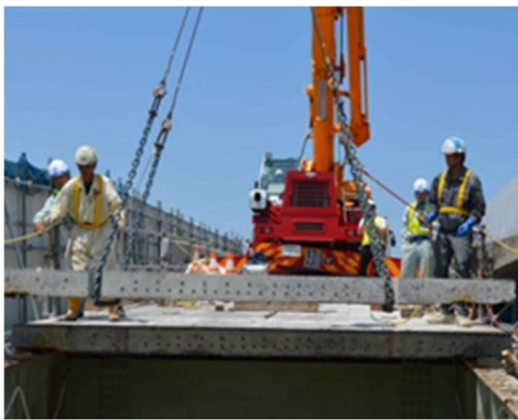
既設床版の撤去状況（玉出入口）
