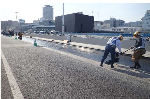
高性能床版防水の施工状況
