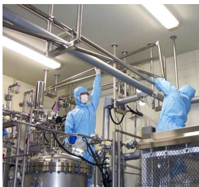
サニタリー配管の据付け作業の様子
