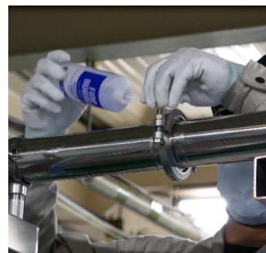
発泡検査剤を利用した「発泡漏れ検査」の様子
