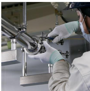
クランプバンドを締めサニタリー管を接合
