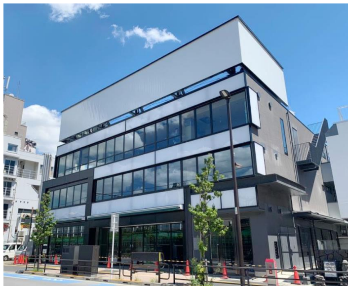
韓国広場 PLUS が営業する第5韓国広場ビルの外観（2024年9月、竣工前の撮影）
