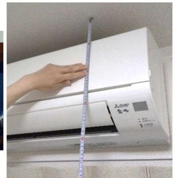
上図のように設置スペースが狭いことがわかっている場合は、室内機のサイズだけでなく、天井や壁、カーテンレールとの隙間も計測している様子を撮影して下さい（上右図）。隙間を考慮せず設置すると、例えば上部の空気の吸い込み口が塞がれてしまうので「冷えない」原因になってしまいます。
