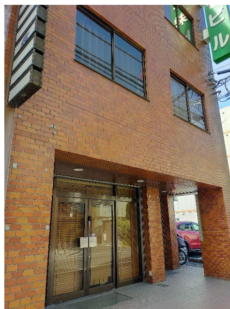
※画像：大宮オフィス外観（宝栄大宮第 5 ビル 4 階）
