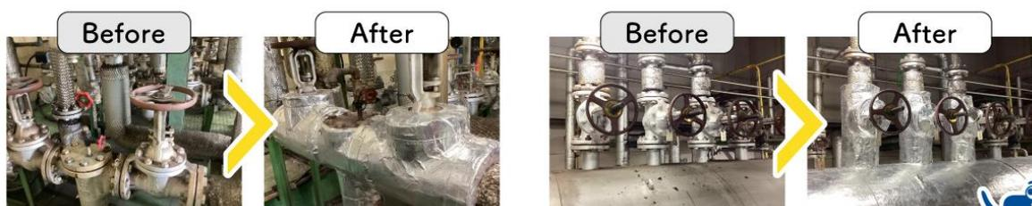
安城事業所内の熱媒ボイラー室において表面温度が 200℃前後の配管機器 29ヶ所が外気にさらされており、非常に大きな熱ロス及び二酸化炭素を発生させている状態でした。カーボンニュートラルの熱ロス対策として対策箇所の選定から断熱材の巻き方のテストなど行いました。
