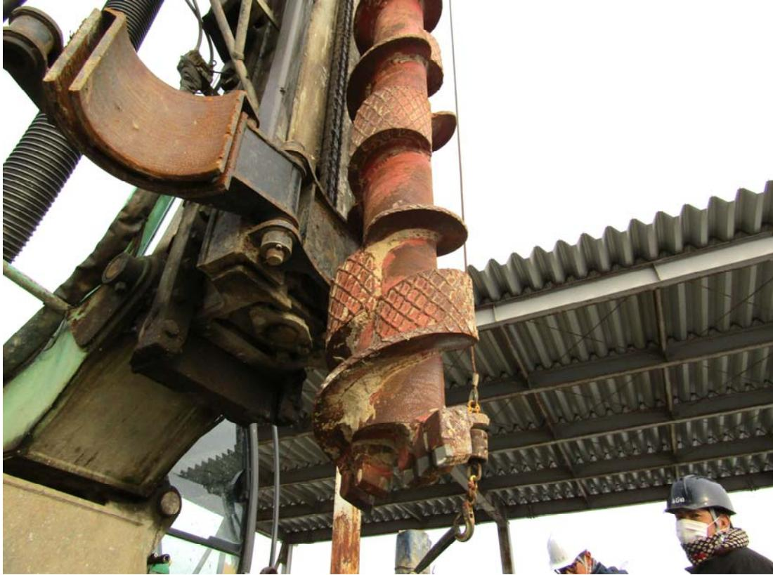
掘削ロッドの先端部に装着したトロウエルスクリュウを回転圧入し、先端地盤や孔壁地盤の密度を高めながら掘削し、所定深度に達した後に、シンプルエコソーダを混入したセメントミルクを注入しながら掘削ロッドを引き上げることで、置換柱体を築造します。
