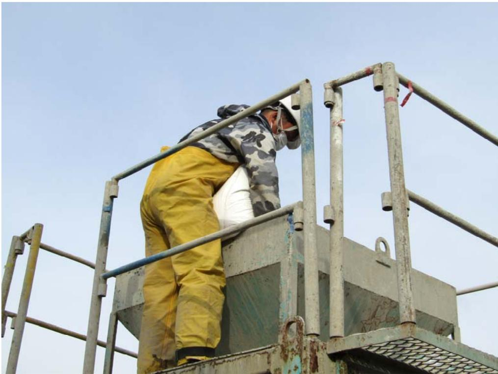
シンプルエコソーダの効果によるセメントミルクの適度な粘性で、孔壁も安定しやすくなります。杭径を太くした仕様を設けたことにより、杭間を空けられるため、偏芯や変形及び欠損などが生じにくく、施工時も安心です。
