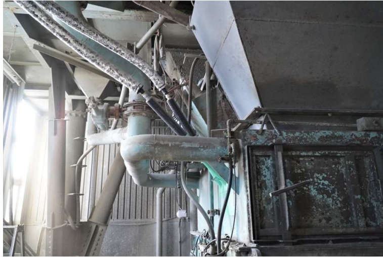
(ミキサー内に液化ガスを注入する配管)
