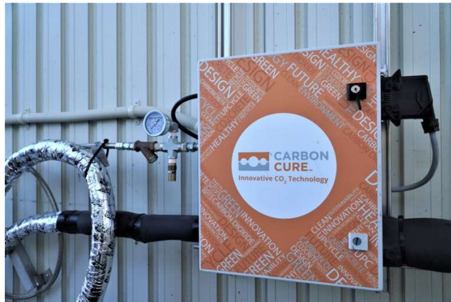
(CO 2 計量装置)
